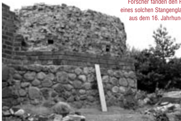
Sanierung des achteckigen Burgturms
